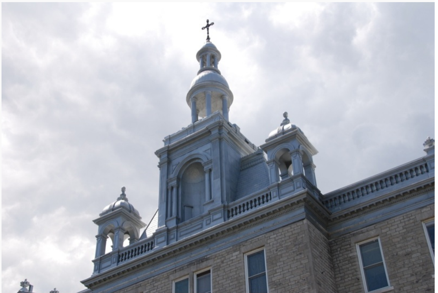
Les photos suivantes nous montrent des détails de la grande qualité du travail de tôlerie et de l'incroyable savoir-faire des artisans du temps. (Photo Gabriel Deschambault )
