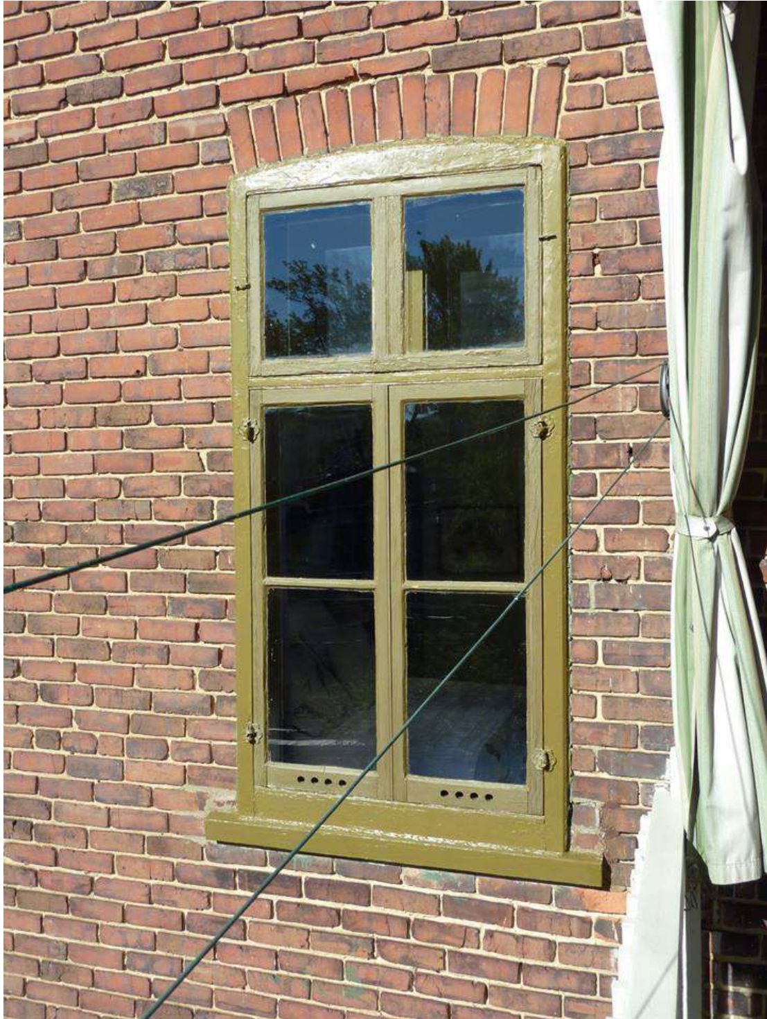
Avec les temps froids on installe les double-fenêtres (ou les contre-fenêtres)
